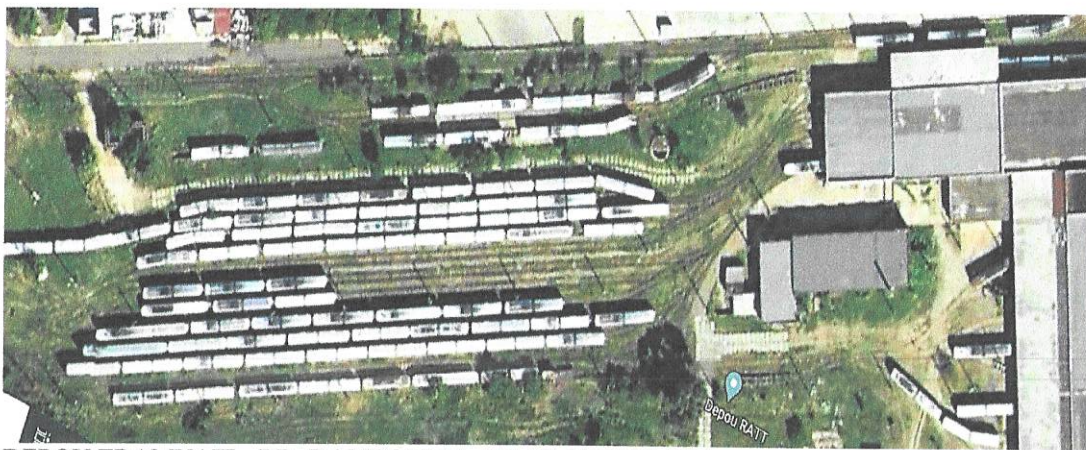
DEPOU TRAMVAIE - BD. DAMBOVITA, NR. 67, TIMIȘOARA
